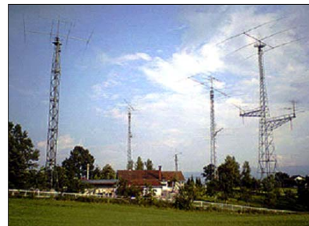
Sl. 108. Antenski sistem stanice YT1AD na lokaciji Vitanovac; Hrane u takmičenjima koristi pozivni znak YT5A
